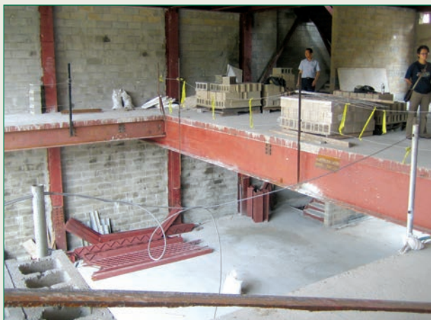
重德佛堂、道學院工地一隅。
